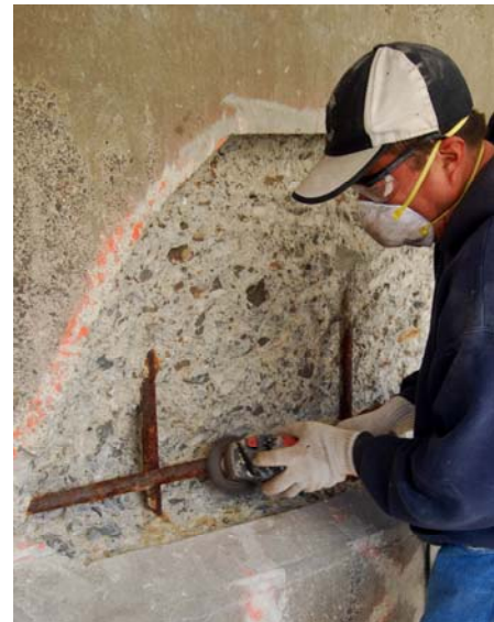
grinding rebar (Nik Epanchin)
